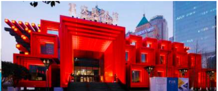
หอศิลป์กัวโกว (อาคารตะเกียบ)
